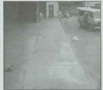
④ 施工完了
