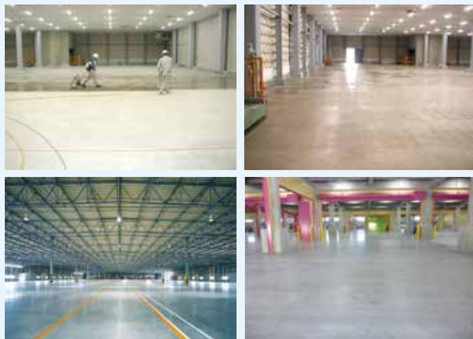
FGS=Floor Grinding System (床研磨システム)の略です
