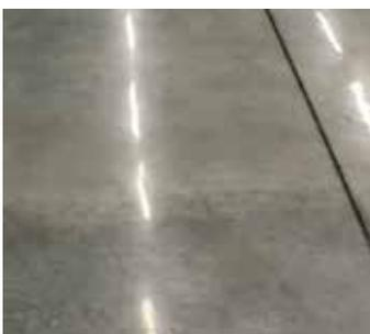
コンクリート打設後の若齢期に、1度シールハードを施工し、その後2週間以上硬化させた後、2回目施工にて研磨を行う仕様です。1回目の施工で表層を強化してから研磨を行うため、骨材模様が出にくく、コンクリートの表情を残したまま、光沢が出ます。但し、**下地は機械式鍍押えに限ります。**
