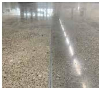
コンクリートの表面状況に合わせてダイヤモンドを選択し、複数工程の研磨を行う仕様です。コンクリートの表層を研削するため、**骨材模様が出ます。**骨材模様は削り深さが深くなるごとに砂目～細石目～粗石目となります。削り深さは、コンクリート表面の硬さや凹凸にもよりますが、0.2mm～数mm程度です。
