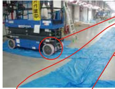
ゴムの油分による床のシミ防止のための高所作業車の車輪にタイヤカバーや養生テープ巻
